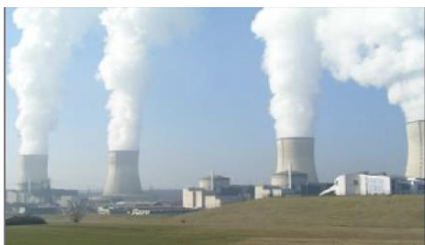
Cheminées de refroidissement d'une centrale nucléaire, libérant de la vapeur d'eau
