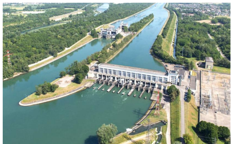
Centrale hydroélectrique de la ville de Kembs, en Alsace.
